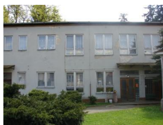
MŠ před rekonstrukcí 2010
